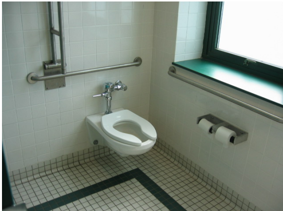
Photo #39: Handicap-accessible toilet stall
